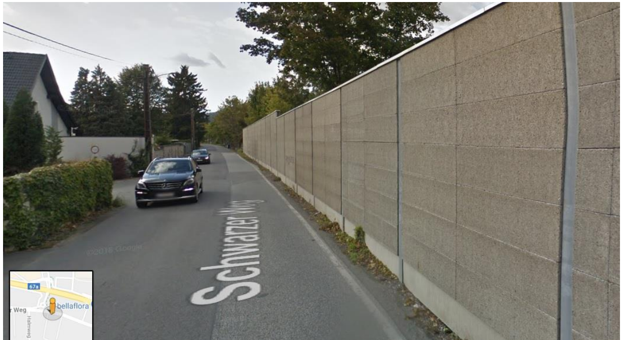
17 Lärmschutzwand aus Sicht des Wohngebiets, Bild Googlemaps
