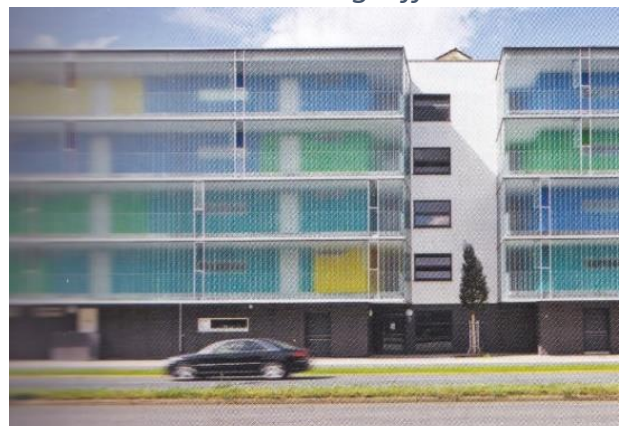
26 Der Laubengang von außen
