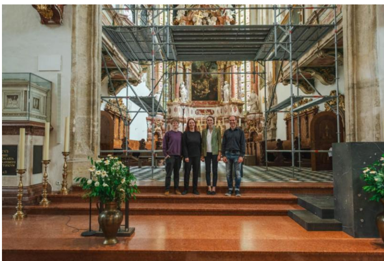
Abb. 10. Baugerüst und Projektteam im Grazer Dom
