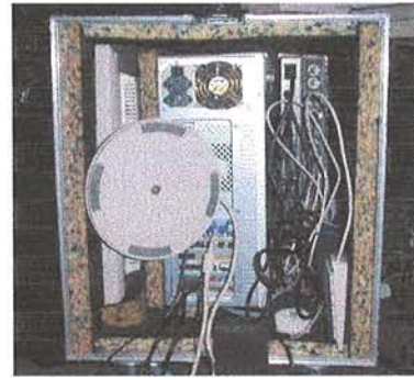
Foto 6: Rückseite der mobilen PD-Station
